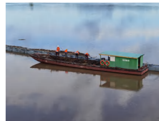
渠河水环境治理现场
